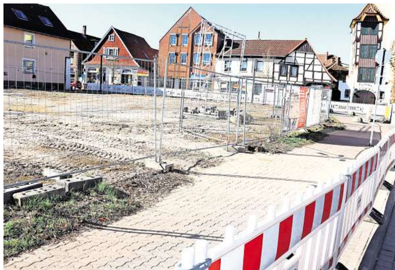
Die Absperrungen stehen bereits: In der nächsten Woche beginnen auf dem Baugrundstück Am Steintor zunächst archäologische Vorarbeiten.
