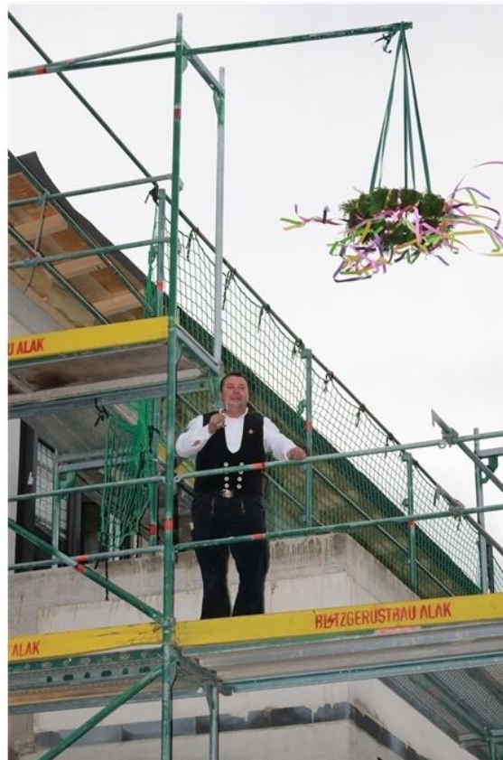
Zimmermeister Sebastian Vogt bei Richtspruch.
